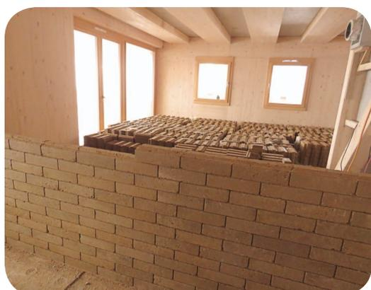
Le projet terrabloc remet au goût du jour la technique du bloc de terre compressée pour la réalisation de murs en maçonnerie écologiques. La matière première? 95 % de déblais d'excavation terreux normalement destinés à la décharge!
